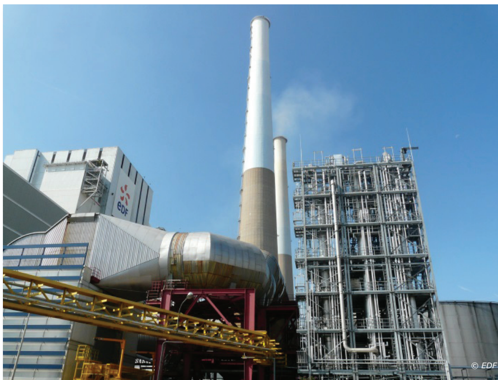
Pilote de captage de CO 2 d'EDF au Havre
